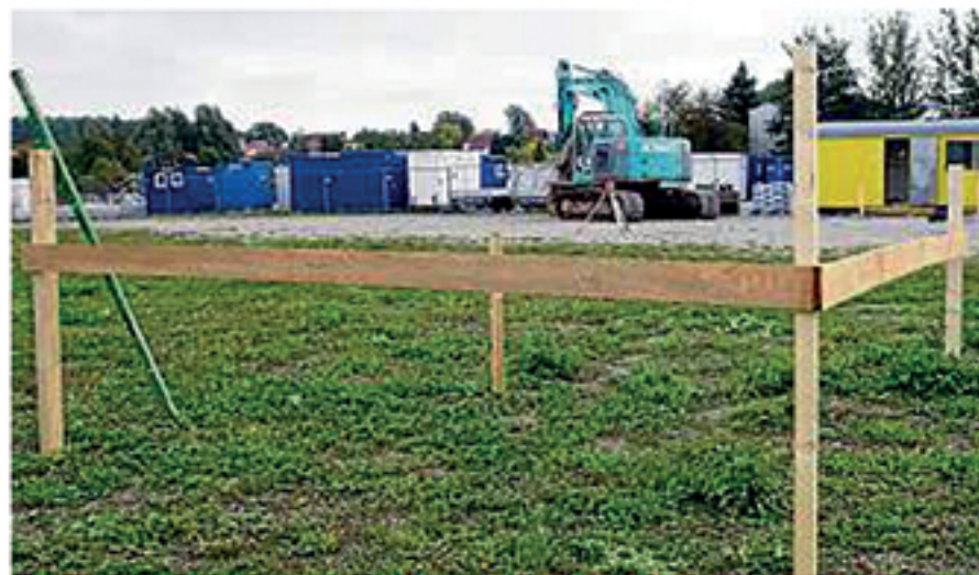
Zunächst muss der Boden für die beiden geplanten Gebäude eingeebnet werden, ehe der Hochbau beginnen kann. Die Höhe der Holzlatten zeigt es an.
